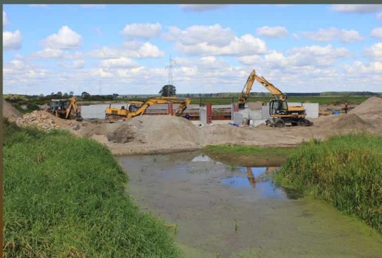
Budowa jazu na Kanale Rudzkim w miejscowości Białogrądy
