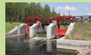
Im Rahmen des Projekts gebautes Stauwehr auf Woźnawiejski Kanal
